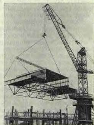
Рис. 1. Подъем блока покрытия.
