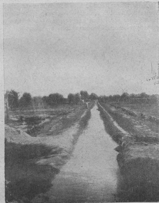
Канал мелкой сети на 6-м распределителе переустроенной Боссага-Керкинской системы. По бокам видны впадины — разрушенные постройки.
