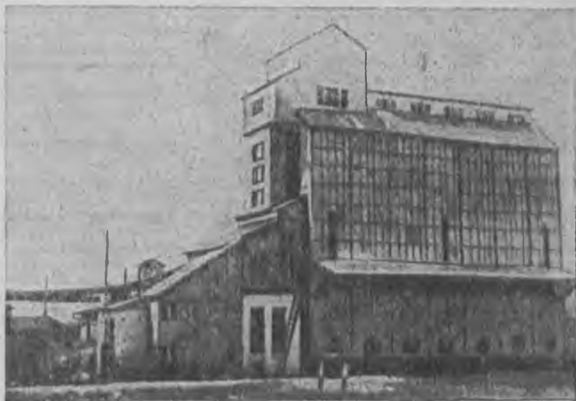
Новый элеватор на ст. Аул, Омск. ж. д. (Казанстан).
