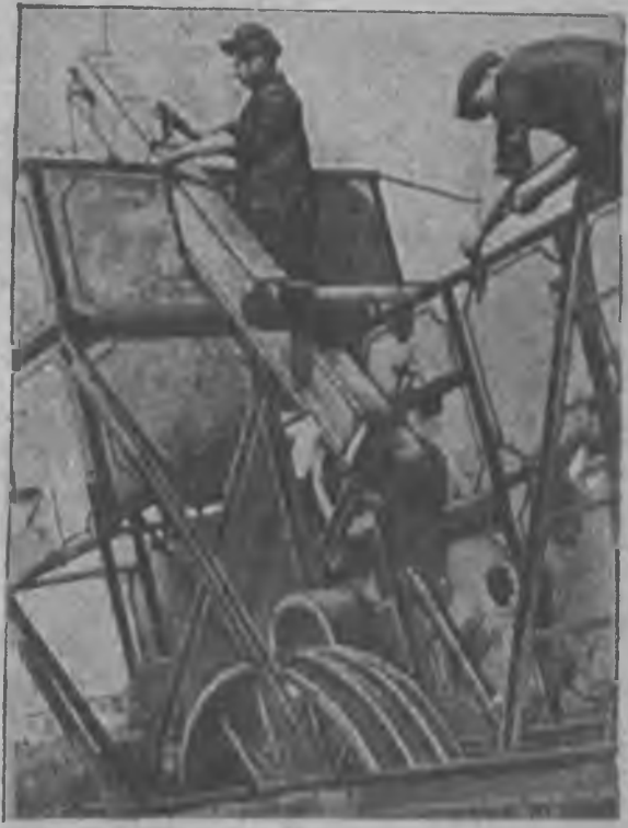
Ремонт комбайнов в зерносовхозе «Серп и Молот», Нижняя Волга.
