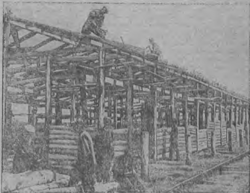
Постройка амбара для хранения овощей на ст. Коротыш (ЦЧО).
