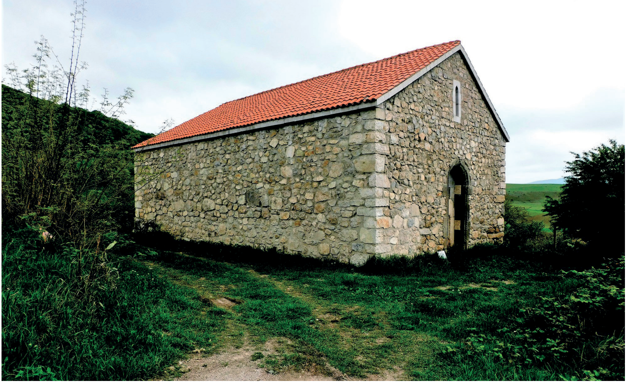
Fig. 29 Église de Pirumachen, vue générale après restauration.
