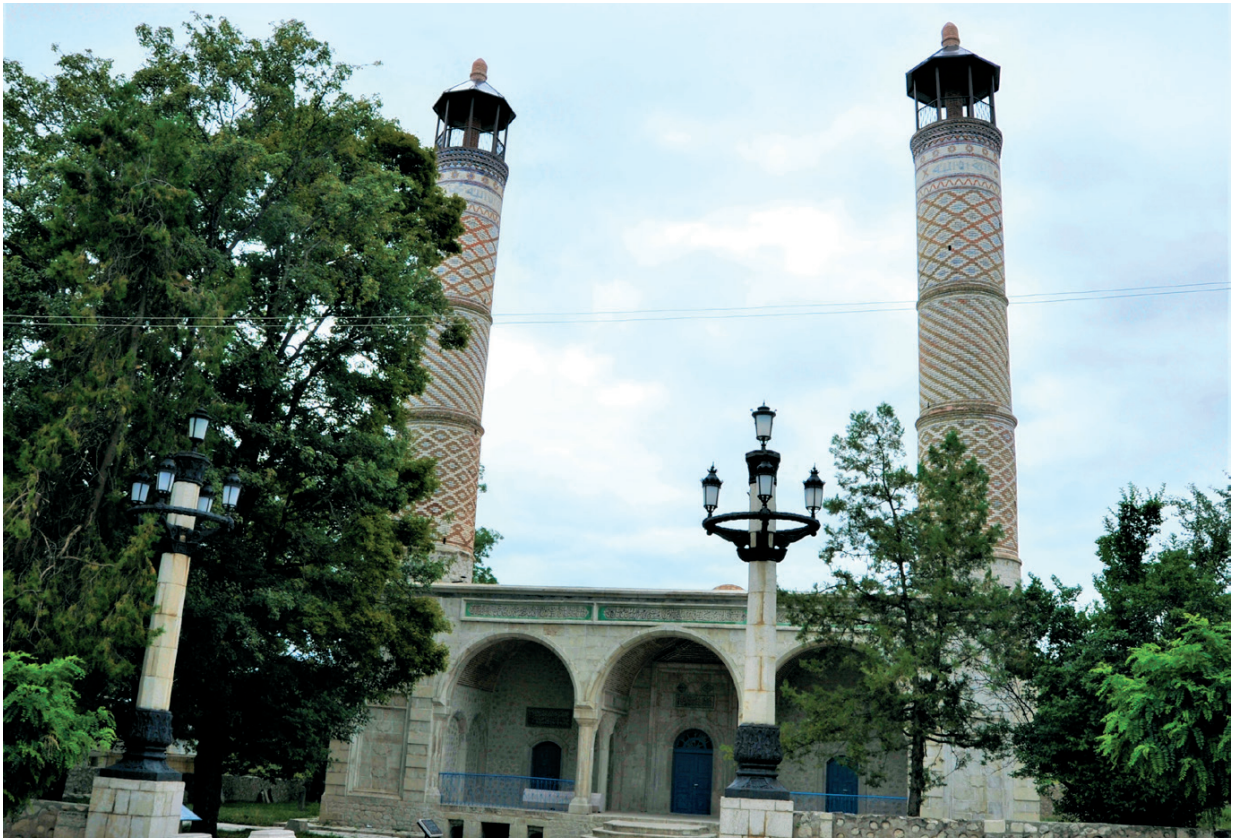
Fig. 30 Mosquée de Gohar Agha à Chouchi après restauration.
