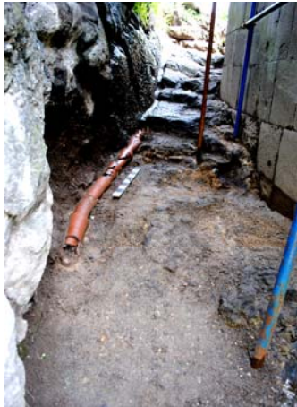
Նկ. 6. Ջրահեռացման առվակոսն ու խողովակաշարը՝ զանգակատան արևմուտքում:
