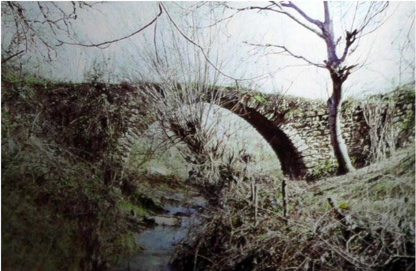
Մահտեսի Արանի կամուրջ, Ավետարանոց գյուղի հարավ-արևելյան եզրին, 1663 թ. (լուսանկարը՝ ըստ Ս. Կարապետյանի, Արցախի կամուրջները, Ե., 2009, էջ 68)
