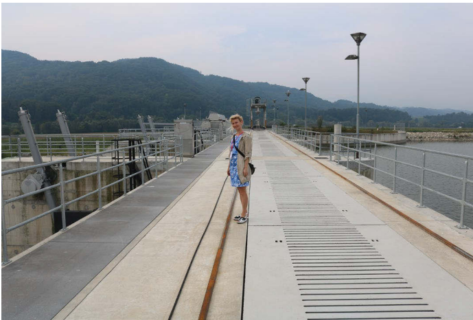
Рис. 1. Гидроэлектростанция НРР в Brežice (47,4 МВт) словенской компании Hidroelektrarne; август, 2019 г.
