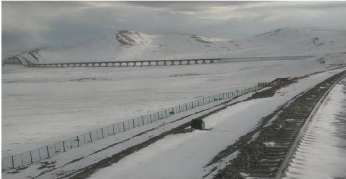
Рис. 3.6. На участке железной дороги Голмуд – Лхаса
