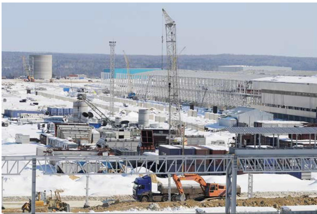
Рис. 4.7. Строительная площадка Богучанского алюминиевого завода
