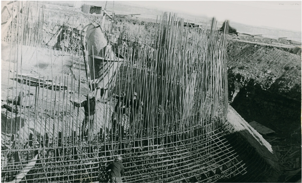
Начало строительства уникальной для СССР 400-метровой трубы для Берёзовской ГРЭС. Экспедиция сектора, 1981
