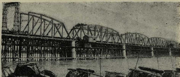
Рис. 6. Строящийся железнодорожный мост.
