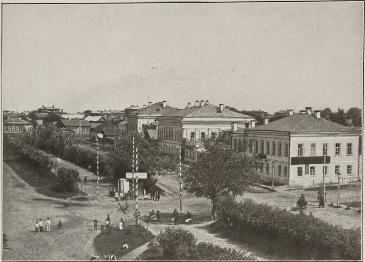
Бульваръ на Большой улицѣ.
