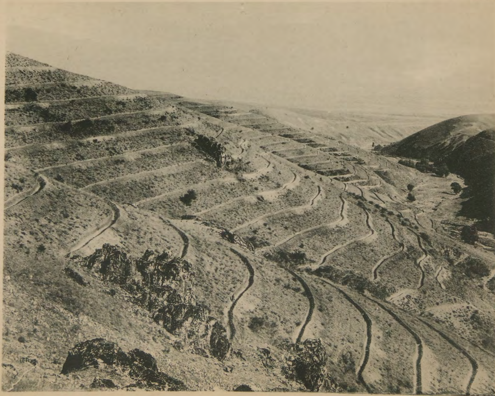
Террасировка горныхъ склоновъ въ 15-25^{\circ} при разстояніи между террасами, по перпендикуляру, въ 3 саж. Видъ на террасы сверху.
