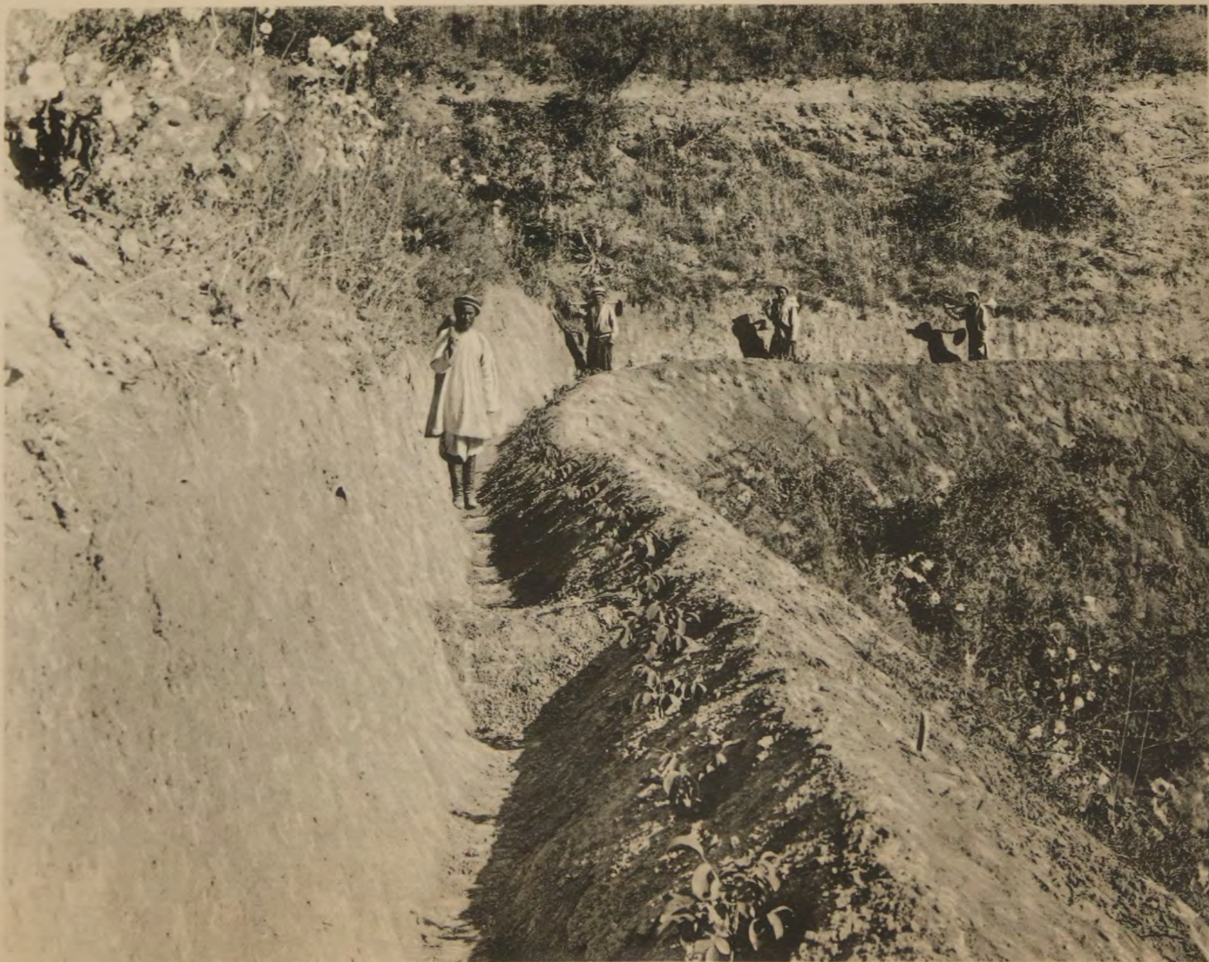
Терраса по горному склону въ 35^{\circ} . Впереди первого, стоящаго въ канавѣ террасы рабочаго, видна перемычка террасы и видны посаженныя по валу террасы 1-лѣтніе саженцы грецкаго орѣха.
