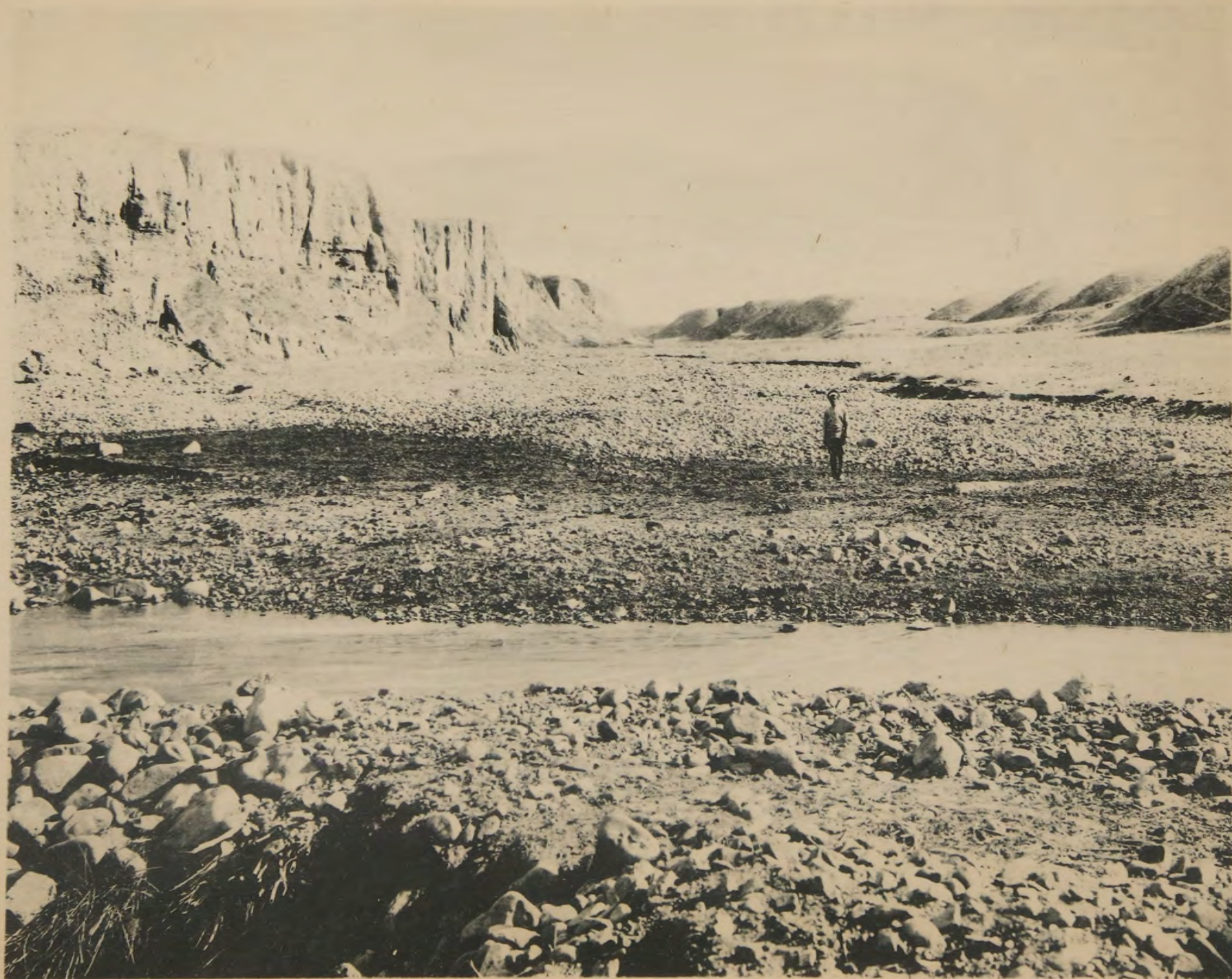
Русло р. Акъ-Ташъ и пересѣкающій его оросительный каналъ Искандеръ въ томъ мѣстѣ, гдѣ онъ разрушается силевымъ потокомъ Акташа.
