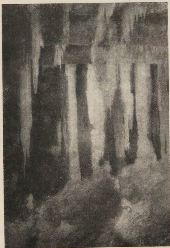
Рис. 17. Ледяные сталактиты въ штольнѣ выемки версты 536-й, разрабатываемой англійскимъ способомъ.
