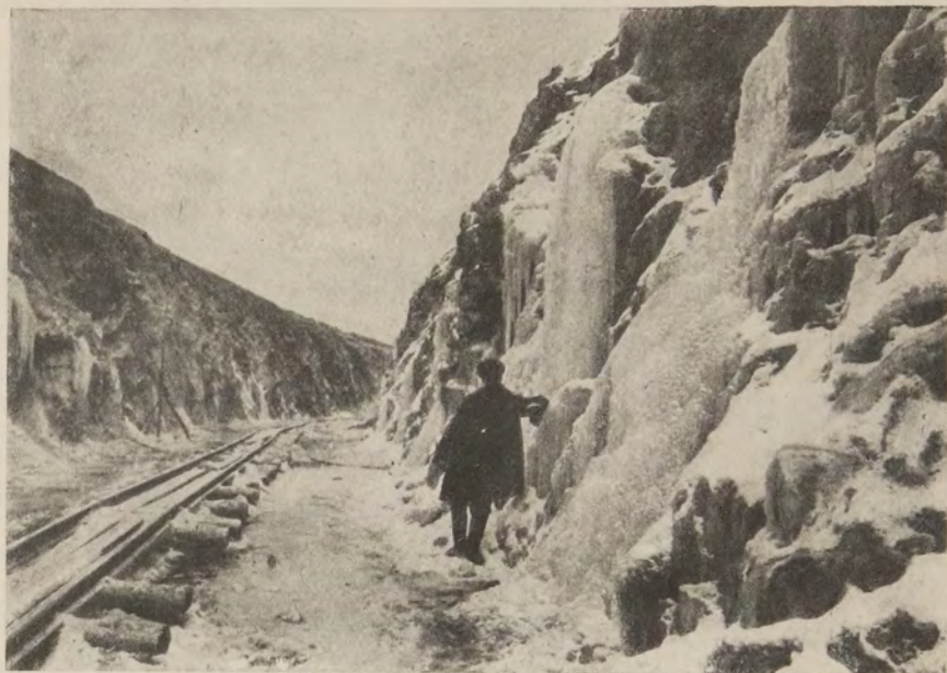
Рис. 9. Наледи на скалистыхъ откосахъ выемки версты 138-й, пикеть № 42-37.
