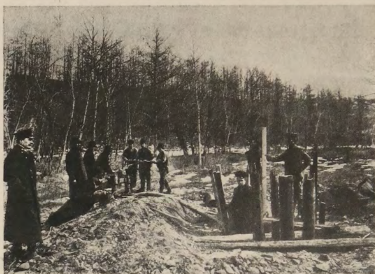
Рис. 1. Изысканіе водоснабженія. Повѣрочныя испытанія притока воды въ шурфахъ при изысканіи водоснабженія по рѣкѣ Бѣлый Урюмъ при станціи «Урюмъ». Верста 1-я.
