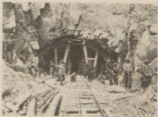
Рис. 8. Западный порталъ тоннеля 128-й версты, Пикетъ № 135.
