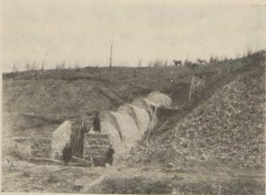
Рис. 7. Каменная труба отверстія 100 саж., расположенная въ Косогорѣ версты 88-й.
