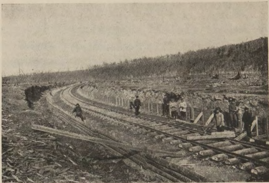
Рис. 3. Укрѣпленіе грязной выемки версты 35-й.
