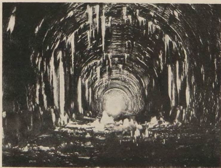
Рис. 20. Внутренній видъ тоннеля версты 587.
