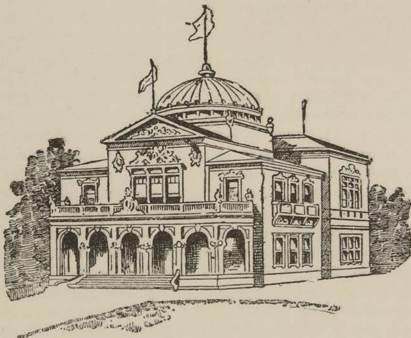
Зданіе Штата Арканзасъ.
