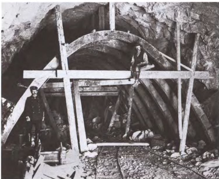
Кладка свода тоннеля № 30 на 59 версте
