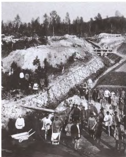
Строители железной дороги на дренажных работах
