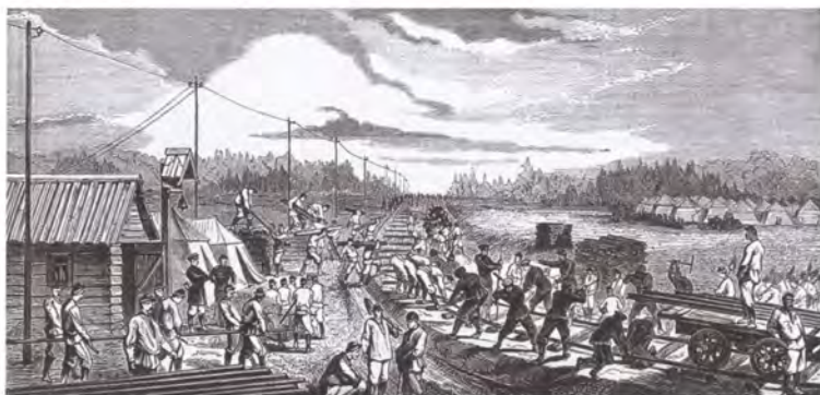
Укладка рельсов. Гравюра Л. А. Серякова
