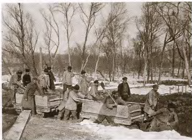
Работы каторжных на постройке Уссурийского участка Сибирской железной дороги. Фото начала XX в.
