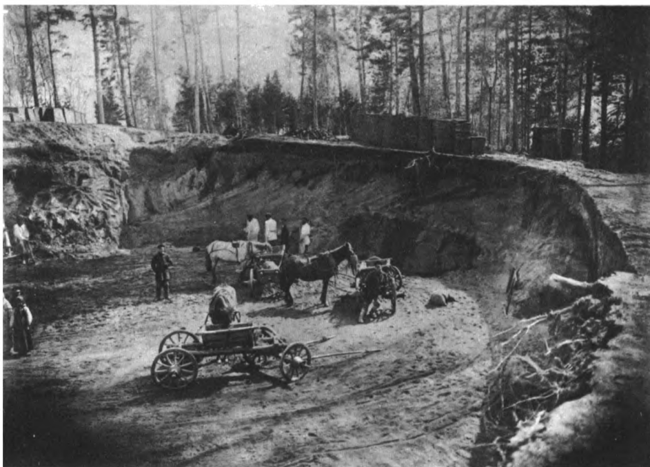
Котлован под церковью во Флёнове
