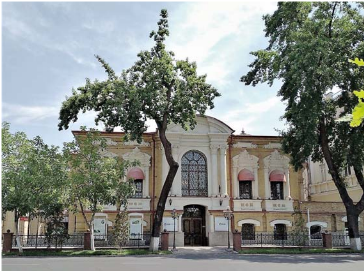
Ташкентский филиал Госбанка, 1893 г. (ныне — филиал Узбекского промышленно-строительного банка) (июль 2020 г., фото Б. А. Алимджанова)
