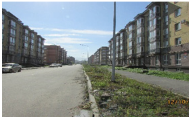
Автомобильная дорога микрорайон 18, г. Владикавказ
