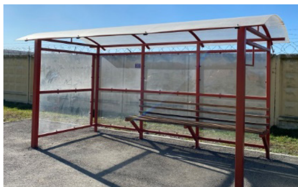
Установленные на объекте автопавильоны
